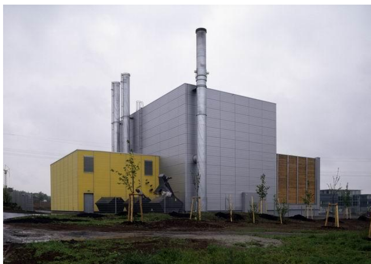
Slika 14 Bioelektrana-toplana (BE-TO) na drvenu biomasu
